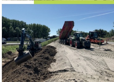
De voorbelasting voor de toekomstige weg bij het Beerpolderviaduct is aangebracht. Het zand blijft een jaar liggen.
